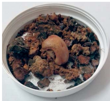
Dosažené výsledky v bytovém domě Družstvo Běluňská v Praze. Zadržené nečistoty a rez ve filtru po cca měsíci používání.
